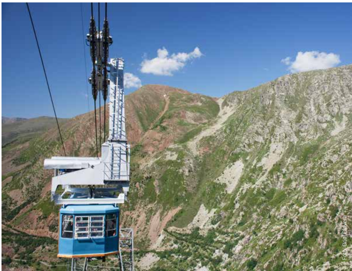
El telefèric de la Vall Fosca permet ascendir fins a 2.200 m al Parc Nacional.
