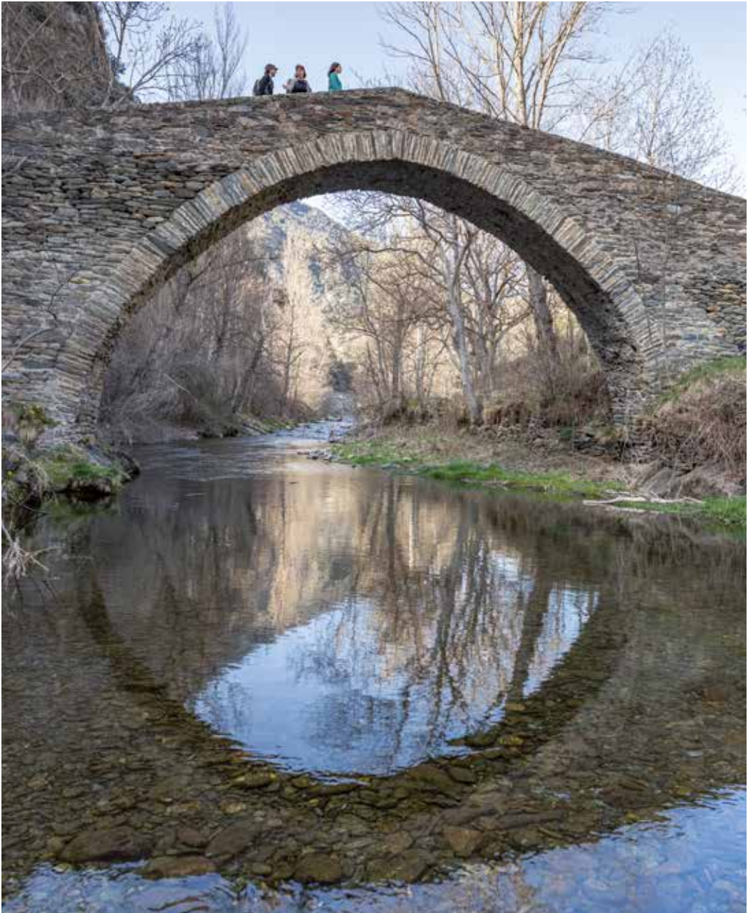
El de Cassibrós és el més gran dels ponts medievals de Cardós: és un notable exemplar romànic fet en una sola gran arcada que s'eleva set metres pel damunt del riu.
