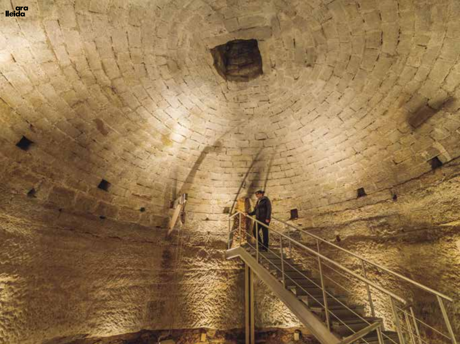
Les dues obertures del pou de gel per dipositar i treure els blocs: una lateral a nivell del terra exterior (la principal, per on accedeixen els visitants) i una altra zenital anomenada "brocal".
