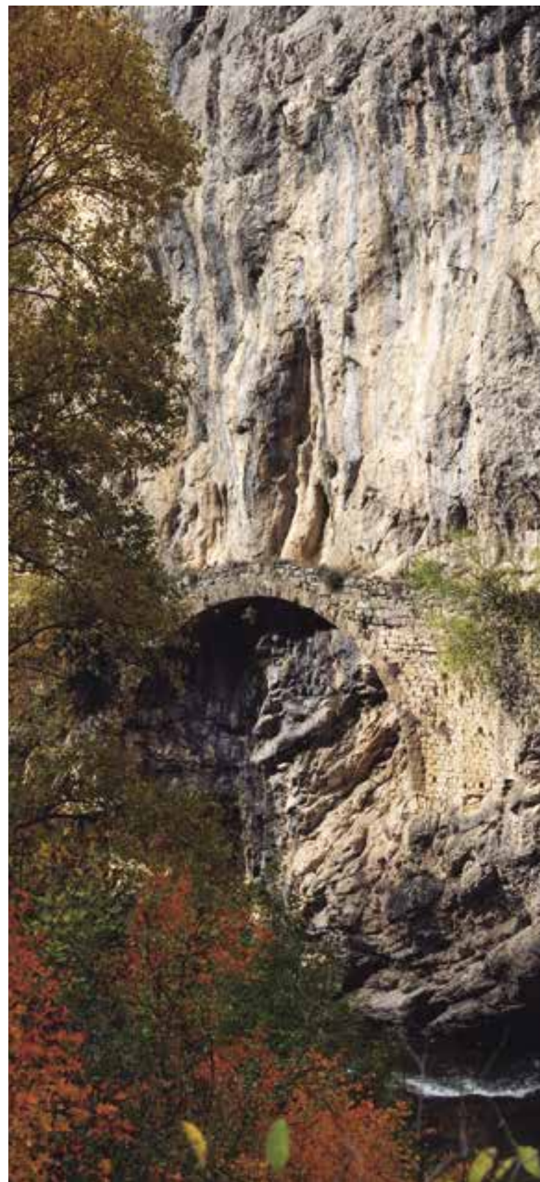
Un dels pontarrons del congost de Trespunts, obra cabdal d'enginyeria medieval.
